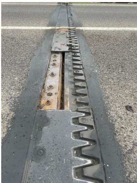
Image 5 : Joint de chaussée
