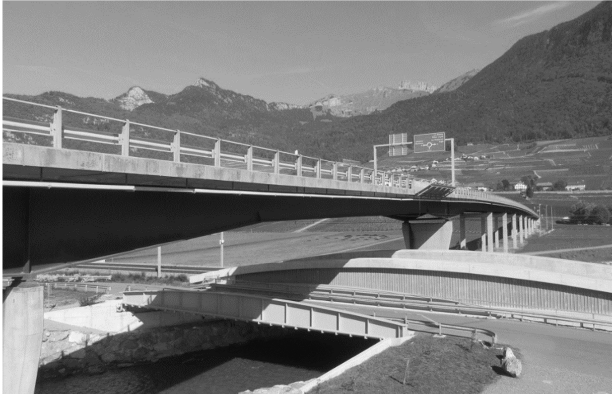
Viaduc d'Aigle franchissant le sentier pédestre, la ligne CFF, la Grande-Eau, et l'accès aux convois agricoles
