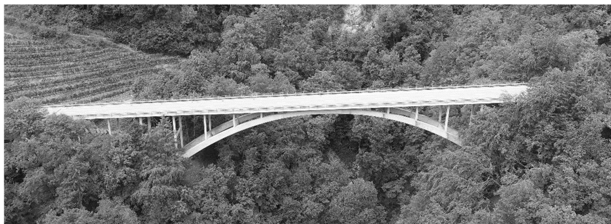
Figure 4. Pont sur le ruisseau du Larrevoin – pont en arc
