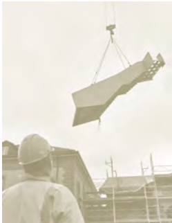
e Installation de l'escalier pendant les travaux
