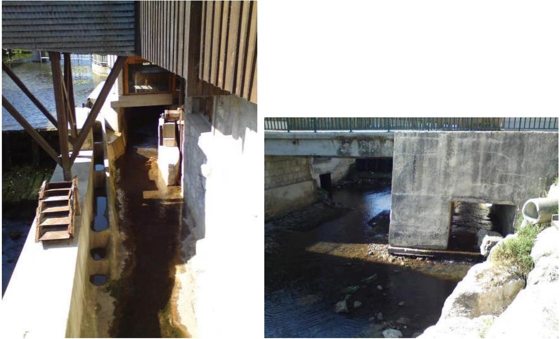
Figure 19: passe à poissons existante et canal de sortie de la passe (à droite)
