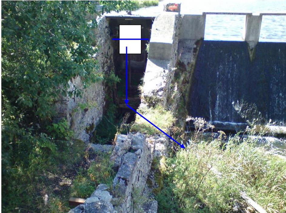
Figure 18: vue du by-pass du barrage des Meuniers et possibilité de passe à poissons
