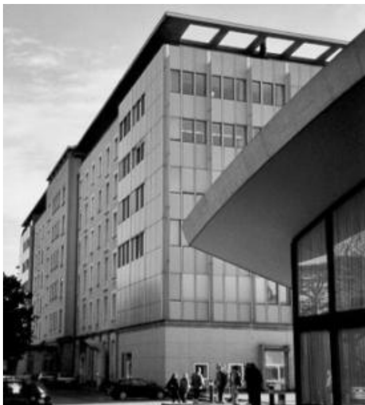
Fig. 1. Le bâtiment Cour 33 de la HEP-VD à Lausanne
