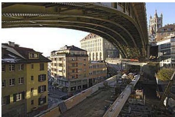
Rame de métro m2 en construction (c) t-l/J. - B. Sieber
