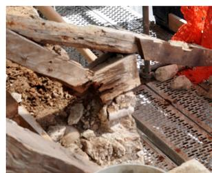
Pourrissement des éléments de charpente dû à une mauvaise gestion de l'évacuation de l'humidité.
