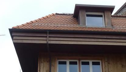
Surplus conséquent de ferblanterie transformant l'avant-toit en un ouvrage massif.
