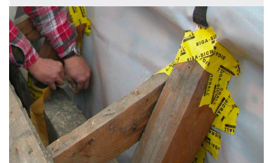
Pose d'un frein-vapeur, difficulté de mise en œuvre, attention aux raccords et aux percements
