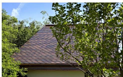
Exemple d'intégration de tuiles photovoltaïques
