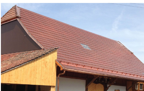
Exemple d'intégration de tuiles photovoltaïques
