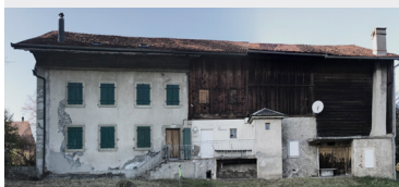
Façade sud-est, côté campagne
