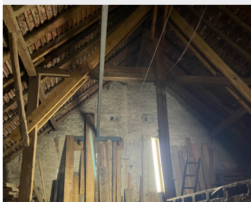
Vue du mur mitoyen côté grange
