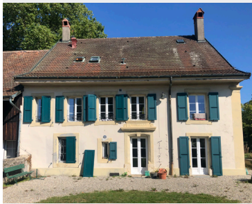
Vue de la façade côté cour
