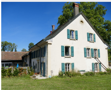
Vue de la façade pignon, du jardin et de la cour
