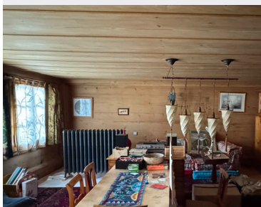
Préservation intérieure de la construction à poteaux remplissage bois de la façade principale Sud
