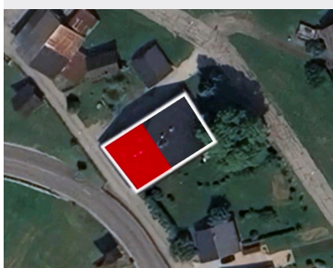
Vue aérienne de l'intégration des panneaux photovoltaïques sur un pan de toiture
