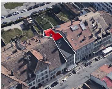
Des panneaux photovoltaïques couvrent les pans de toiture côté lac peu visibles
