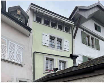
Crépi isolant minéral sur la façade arrière plus modeste
