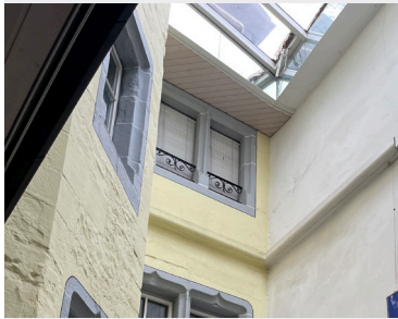
Cour intérieure couverte avec triples vitrages et ouvrants automatiques
