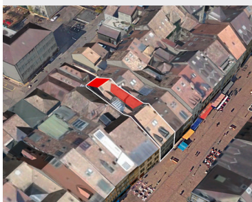
Tuiles photovoltaïques côté rue arrière et panneaux solaires sur cour
