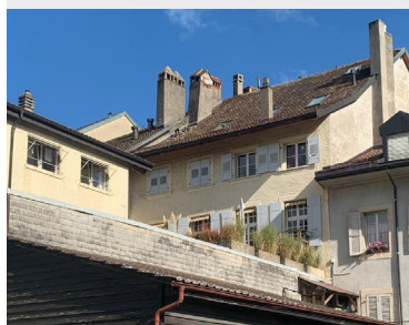
Façade crépie côté rue secondaire
