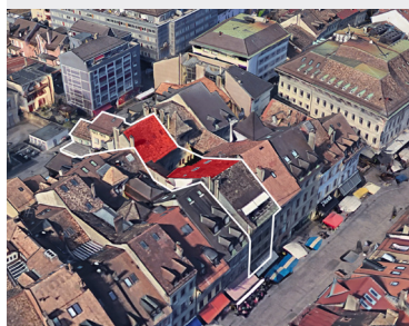
Les pans de toiture côté cour sont couverts de tuiles photovoltaïques
