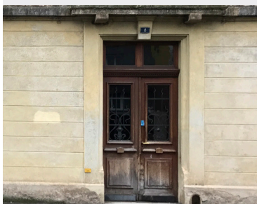
Porte d'entrée en bois avec simple vitrage préservée avec sas d'entrée
