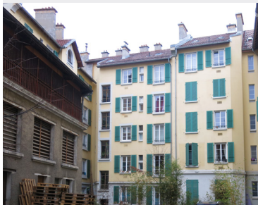
La façade cour plus modeste permettrait une revalorisation avec des balcons
