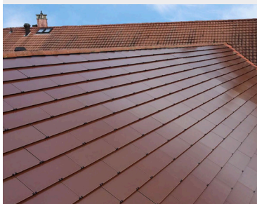
Les panneaux rouges remplacent les tuiles et s'intègrent dans le contexte Référence voir fiche méthodologie
