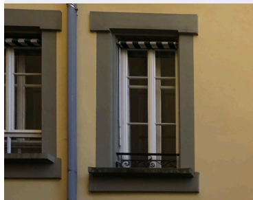
Fenêtres d'origine avec deux fenêtres avec simple vitrage
