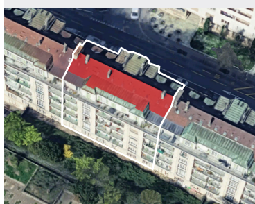
Vue aérienne de l'intégration des panneaux photovoltaïques sur la toiture côté parc.
