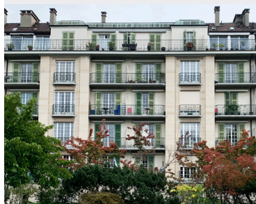
Vue de la façade sud.
