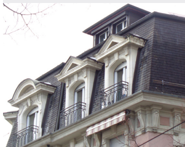
La toiture est recouverte d'ardoises et isolée entre et sur chevrons.
