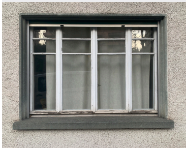
Préservation des fenêtres en bois d'origine et des encadrements
