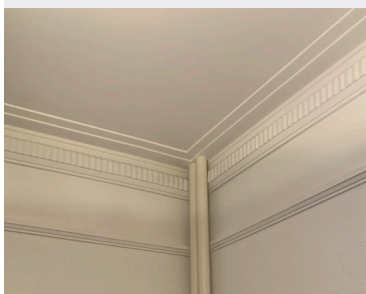
Moultures intérieures. Reprise du motif au plafond pour la coupure des ponts thermiques.
