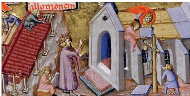
**LA COUVERTURE** Couvriers posant une toitures de tuiles canal. Construction du Temple de Salomon. Après 1331. © BnF
