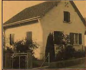
Seigneux, villa rue Centrale
