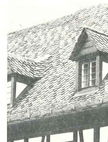
Souplesse du matériau à la mise en œuvre.
