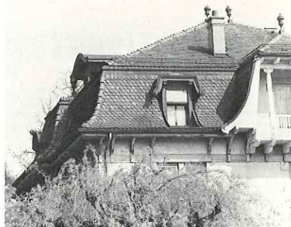
Toit à la Mansard.
