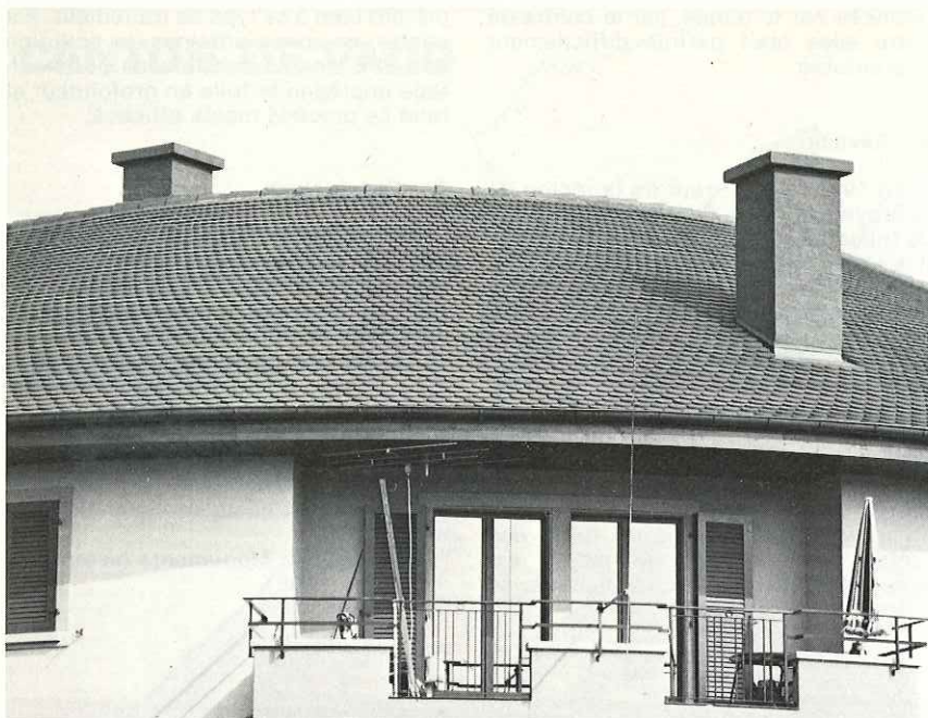
Souplesse du matériau à la mise en œuvre: tuiles gironnées à la fabrication.
