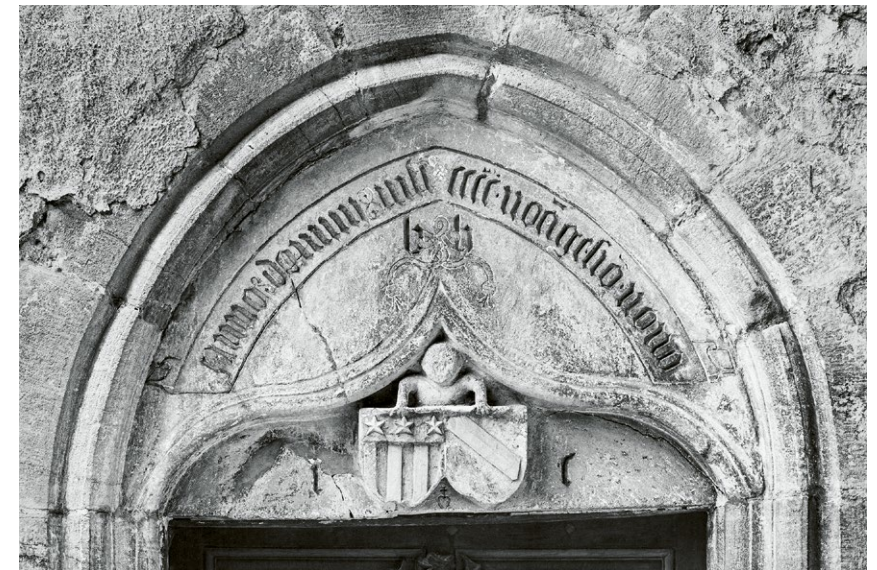
I11.13 Porte d'entrée de l'aile est surmontée des armoiries de Barthélémy de Montferrand-La Sarraz et de sa femme Huguette de St-Trivier ainsi que la date 1499, 1987.
