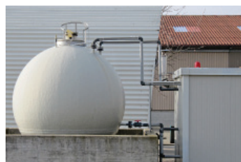
Photo 6: cuve tampon hors sol avec bac de rétention (AGRIDEA).
