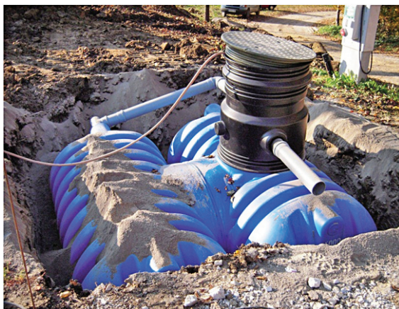
Photo 7: cuve enterrée avec double manteau (L. Chevalier).
