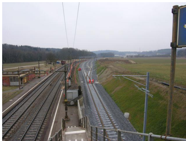
Gare de Vufflens-la-ville avec construction du raccordement ferroviaire, 2005-2006
