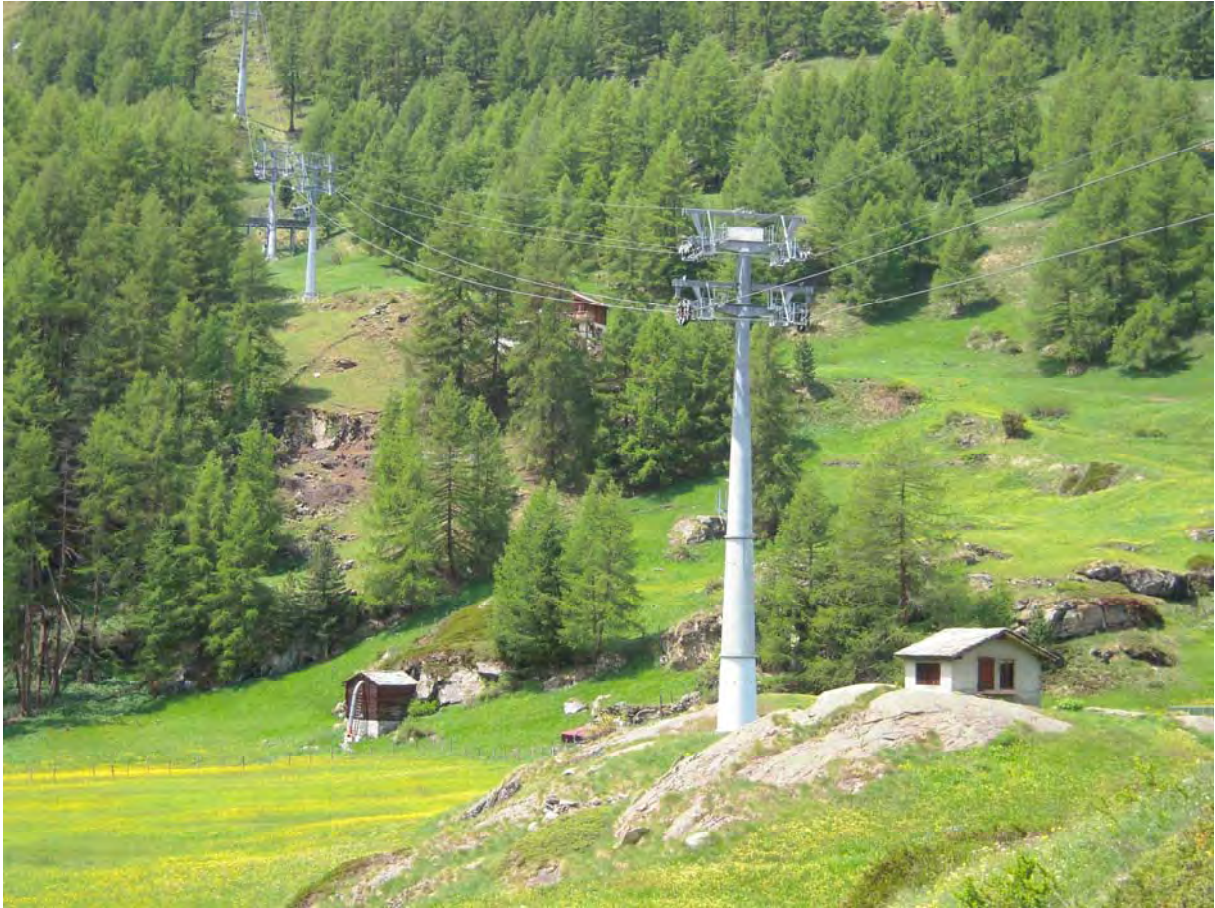
Illustration 2 : Les pylônes de télécabines présentent des dimensions généralement importantes, avec un effet marqué dans le paysage. En forêt, le tracé de l'installation nécessite des défrichements temporaires et définitifs ou des limitations de la hauteur de la forêt.
