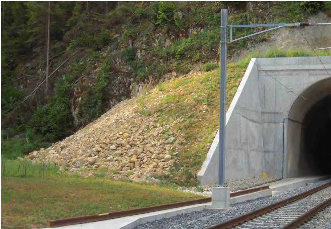
Illustration 56 : le SER a dirigé les travaux d'aménagement du talus en bord du portail du tunnel, pour assurer une intégration paysagère optimale et également réutiliser au mieux les matériaux sur site. Remplacer par un exemple d'un domaine skiable
