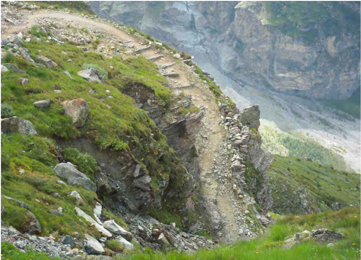
Illustration 45 : outre les chemins historiques portés à l'inventaire IVS, de nombreux vieux chemins de desserte des alpages marquent le paysage. La réalisation de nouvelles pistes carrossables pour le ski peut entraîner leur disparition. Il convient de les préserver, voire de les restaurer si nécessaire (mesure de remplacement) et de les valoriser comme itinéraires pédestres.
