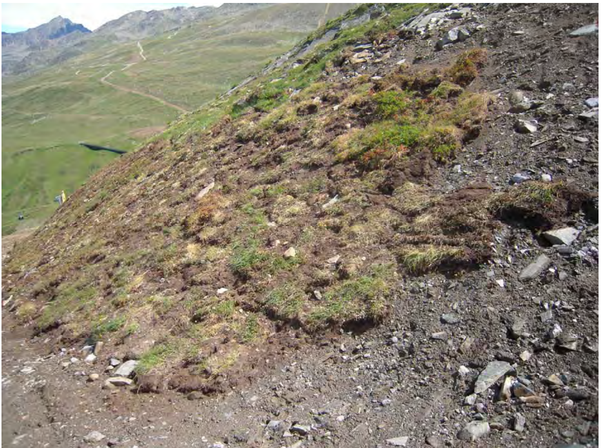
Illustration 60 : Réutilisation immédiate des mottes de végétation sur le talus d'une nouvelle piste. Celles-ci n'ont cependant pas été fixées, malgré la forte pente du talus.
