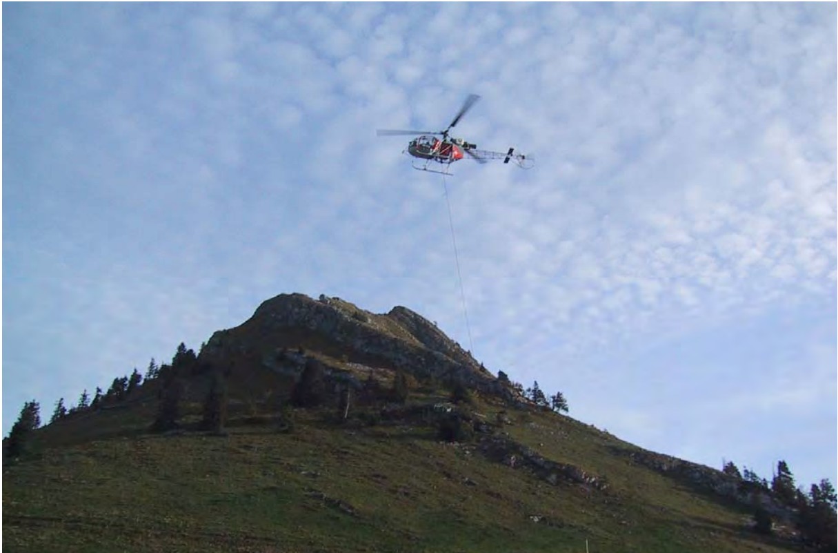
Illustration 1 : L'hélicoptère est très utilisé dans les travaux en altitude. S'il permet de limiter les atteintes au sol (pas de piste de chantier par exemple), il représente un facteur important de nuisance sonore.
