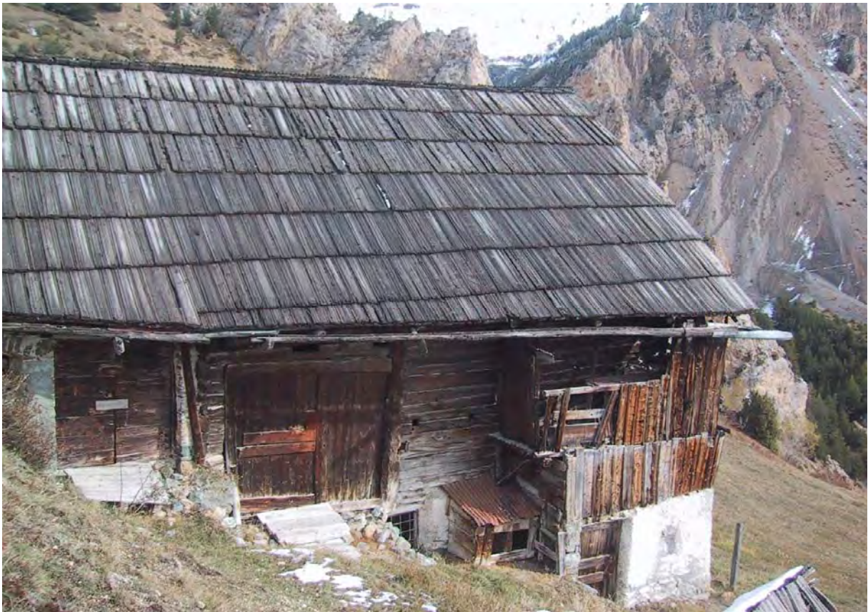
Illustration 55 : la conservation d'un tel bâtiment agricole pourrait passer par sa reconversion en buvette sur les pistes, particulièrement attractive au plan touristique, pour autant que cela soit compatible avec le respect des normes légales et que cela ne nécessite pas d'adjonctions ou de constructions supplémentaires.
