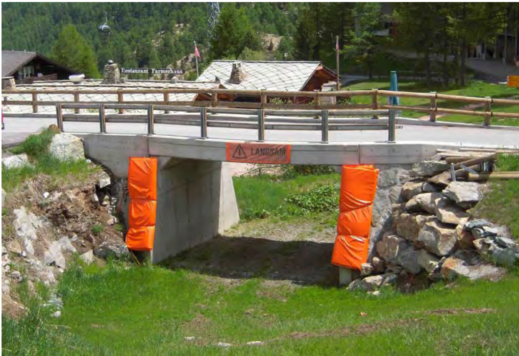
Illustration 11 : de nombreux ouvrages sont réalisés pour permettre le franchissement de voies de circulation. Le recours à des matériaux naturels (pierre) et le retrait des protections en période estivale permettrait de réduire leur impact paysager.
