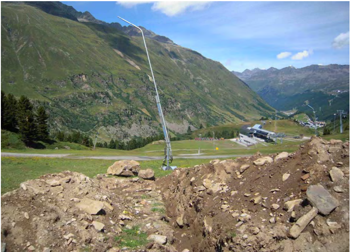
Illustration 10 : L'alimentation des canons implique de nombreuses fouilles, avec des risques d'atteinte aux milieux naturels et aux sols.
