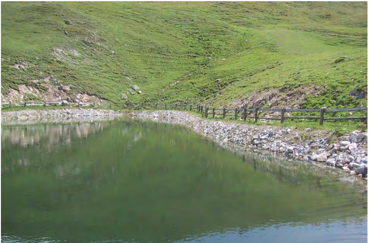
Illustration 49 : Un soin particulier doit être apporté pour la réalisation des bassins pour l'enneigement mécanique, notamment en les intégrant dans la topographie naturelle.
