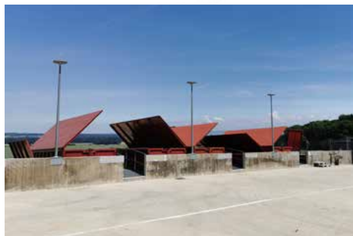
Figure 3: Déchèterie communale de St-Oyens.
