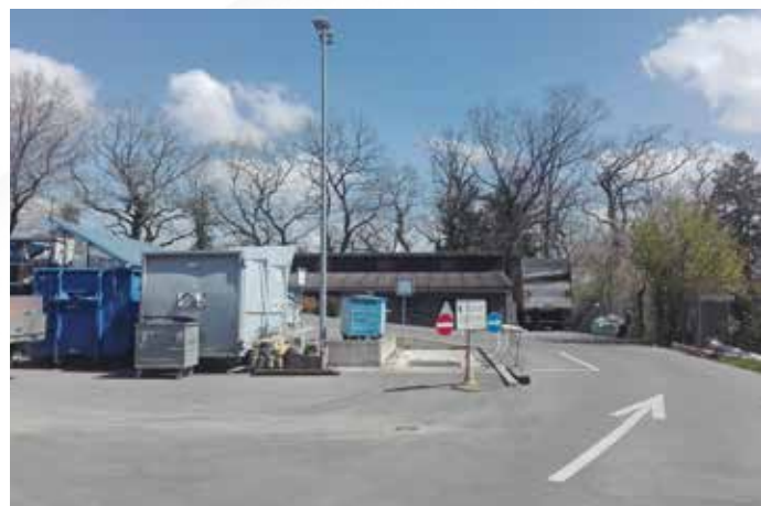
Figure 4: Voies de circulation, déchèterie communale de Cossonay.
