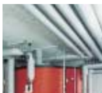
Les conduites bien isolées conservent la précieuse chaleur.
