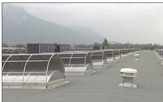
**Exemple de protections solaires par l'extérieur en toiture avec groupes de rafraîchissement d'air (caissons noirs).**
