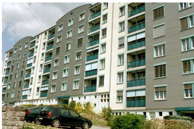
Figure 6 Bâtiments rénovés de l'Avenue d'Aoste
