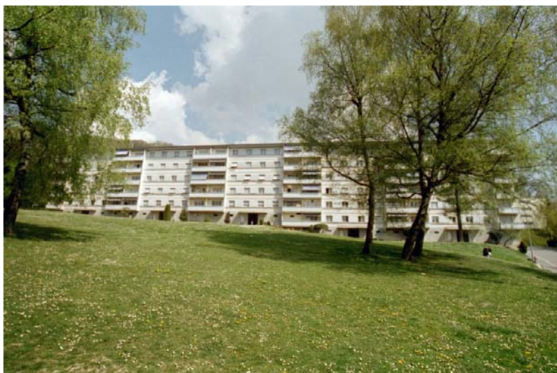
Figure 11 Façade ouest de l'immeuble du chemin de la forêt.
