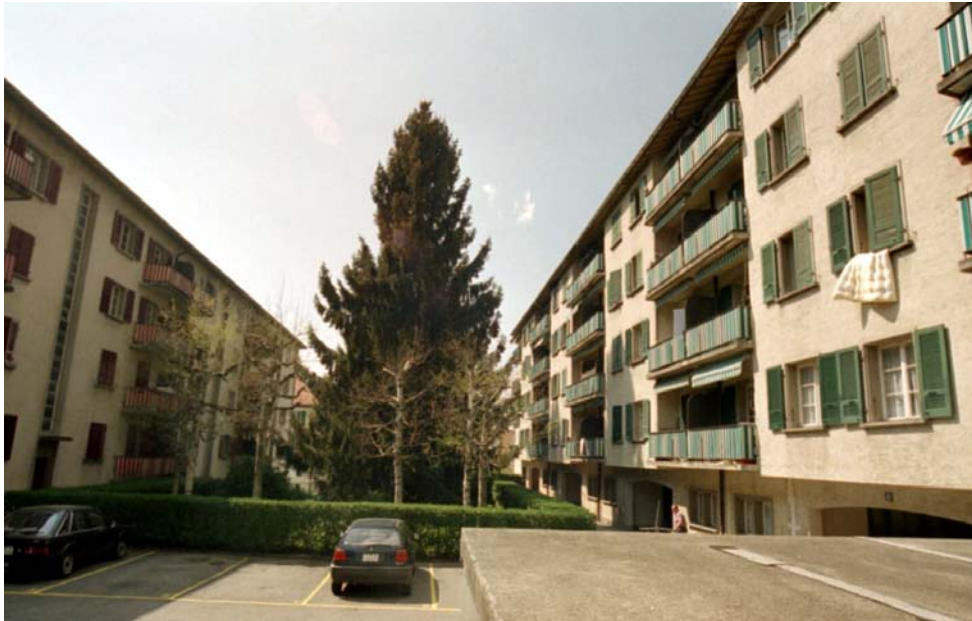
Figure 7 Les bâtiments vus de la route du Pavement.
