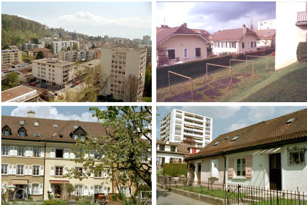
Figure 34 Des typologies de construction très diverses.
