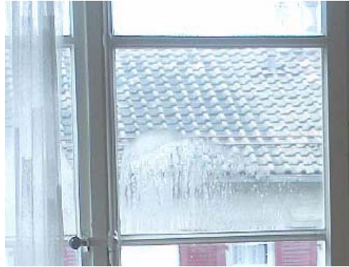
Figure 10 Condensation à l'intérieur du double vitrage
