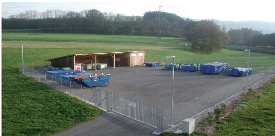
Les déchèteries ont fait leur preuve comme premier maillon du dispositif de tri et de recyclage des déchets (Commune de Curtilles)
