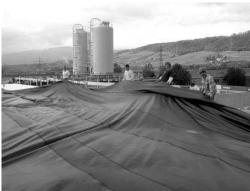
L'étanchéité EPDM se déroule rapidement, sa mise en place n'est que peu dépendante des conditions météorologiques.
