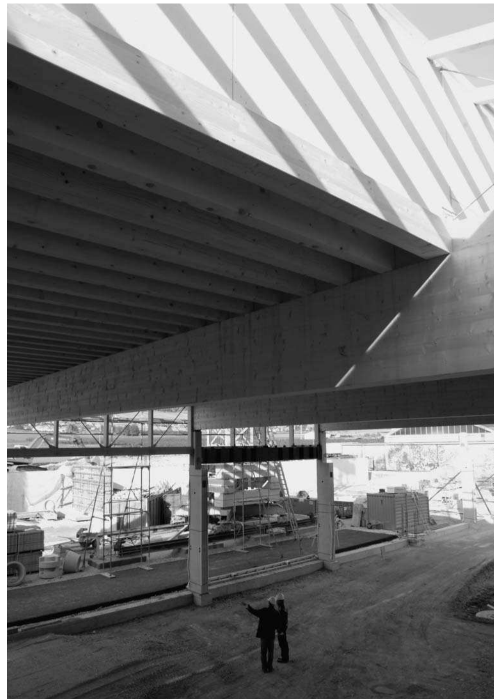
Le chantier: vue intérieure, novembre 2004
