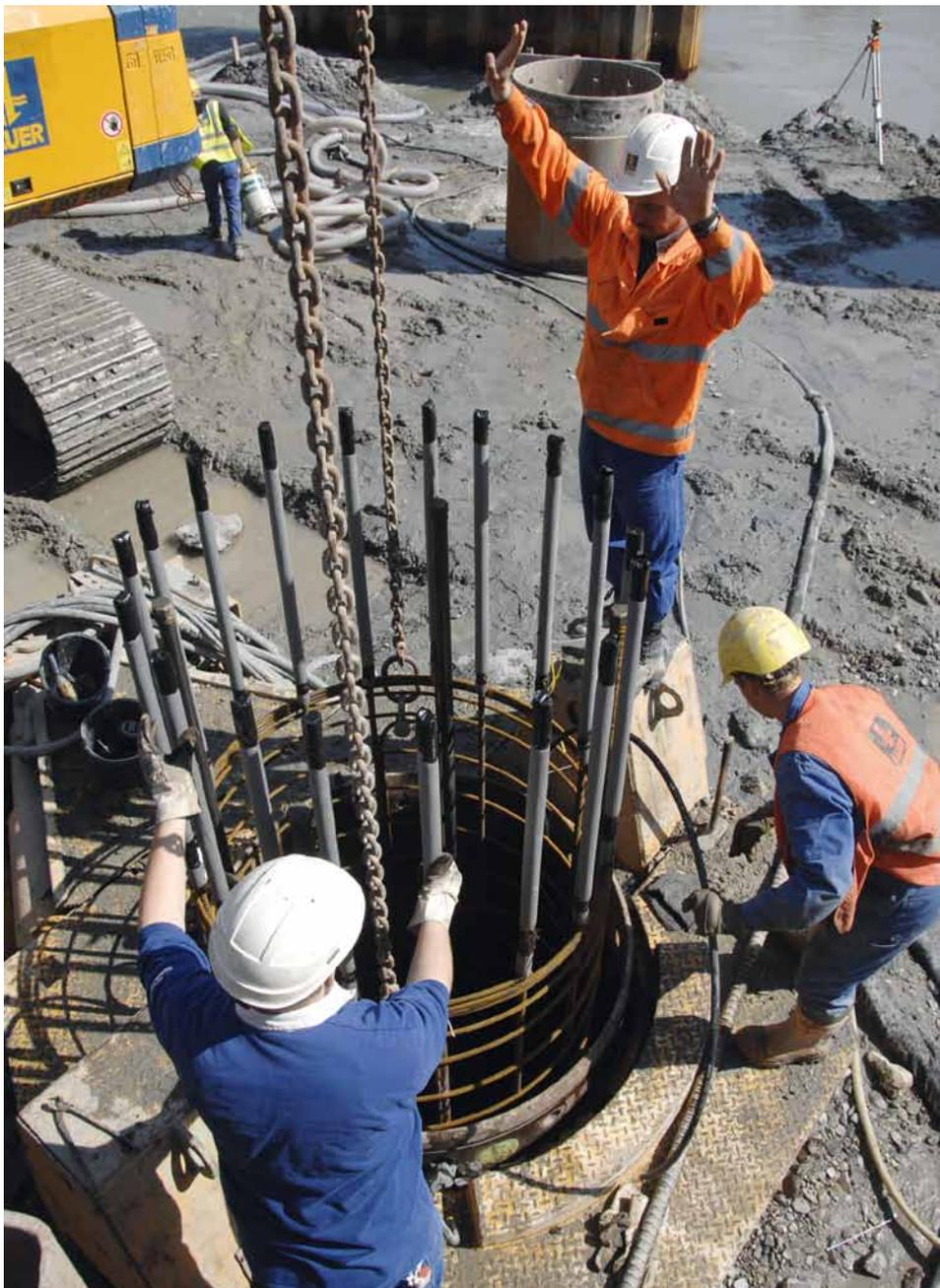
Construction d'un pieu de fondation pour le viaduc sur le Rhône (H144)
