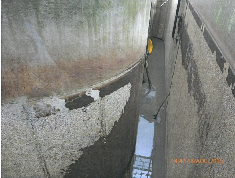
Exemple d'érosion du béton dans un bassin à boues activées de la STEP de Savigny
