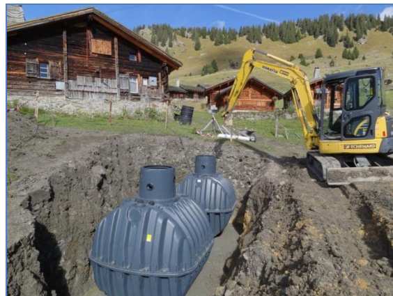
Installation d'une « mini-STEP » sur un alpage / YAPI Nyon
