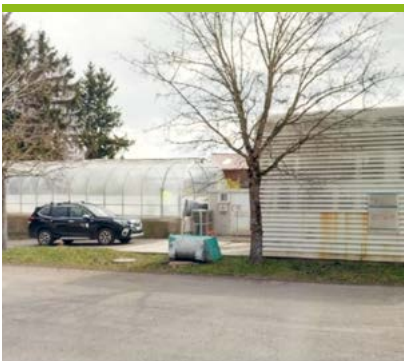
Places de lavage pour les pulvérisateurs et les machines
