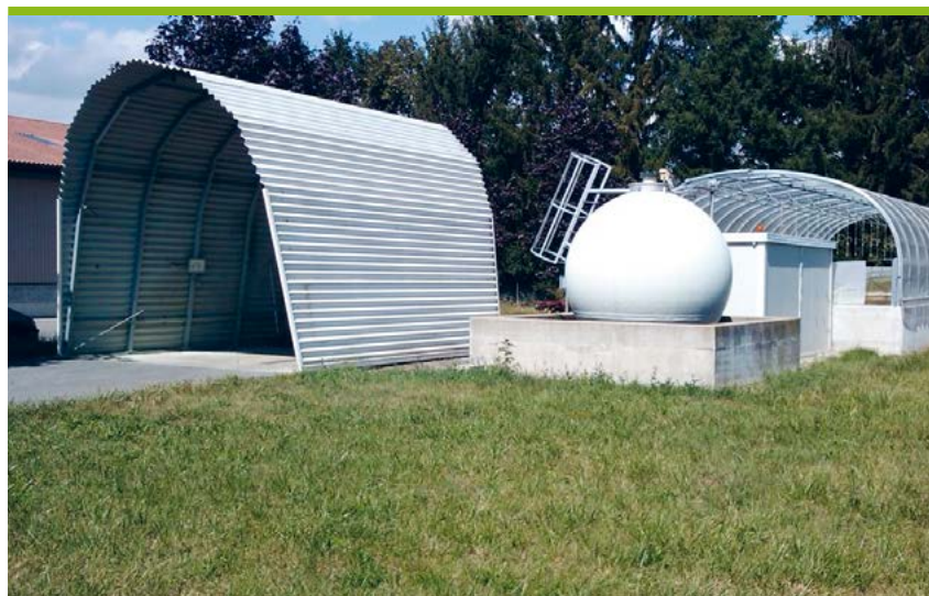
Différentes modifications des infrastructures seront nécessaires afin d'adapter la place de lavage de Denens aux exigences légales actuelles.
