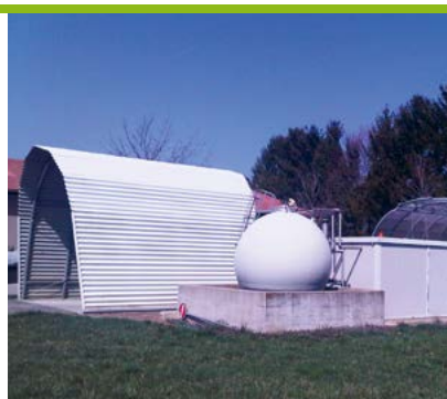
Tunnel du biobac
