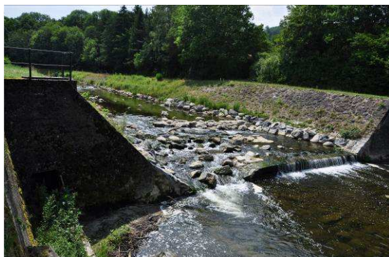
Figure 23 : Nouvelle rampe rugueuse de Valacrêt (En Bressonnaz)
