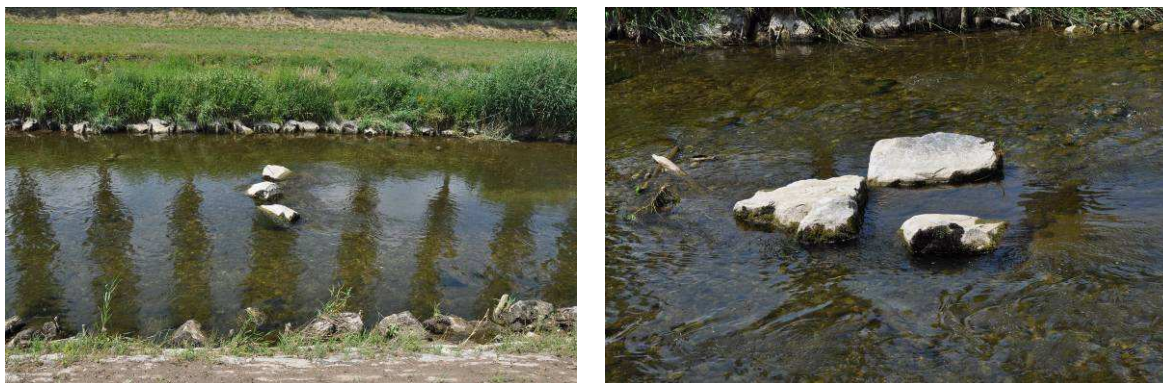
Figure 24 : Ajout de gros blocs pour l'abri des poissons. Secteur Moudon-Lucens.
