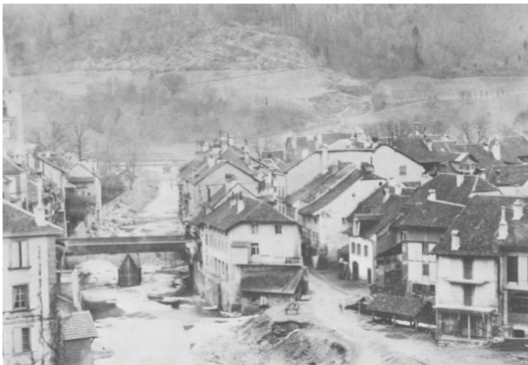
Figure 16 : Moudon, après la crue de la Broye du 3 octobre 1888, in Chuard & Faucherre (1976)
