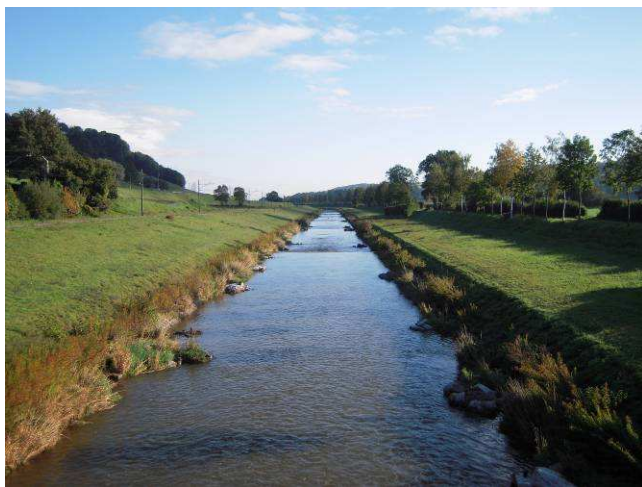
Figure 19 : Illustration du profil trapézoïdal de la Broye dans le secteur Moudon-Lucens.
