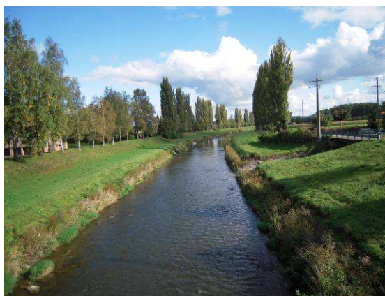
Figure 31 : Talus de la Broye
