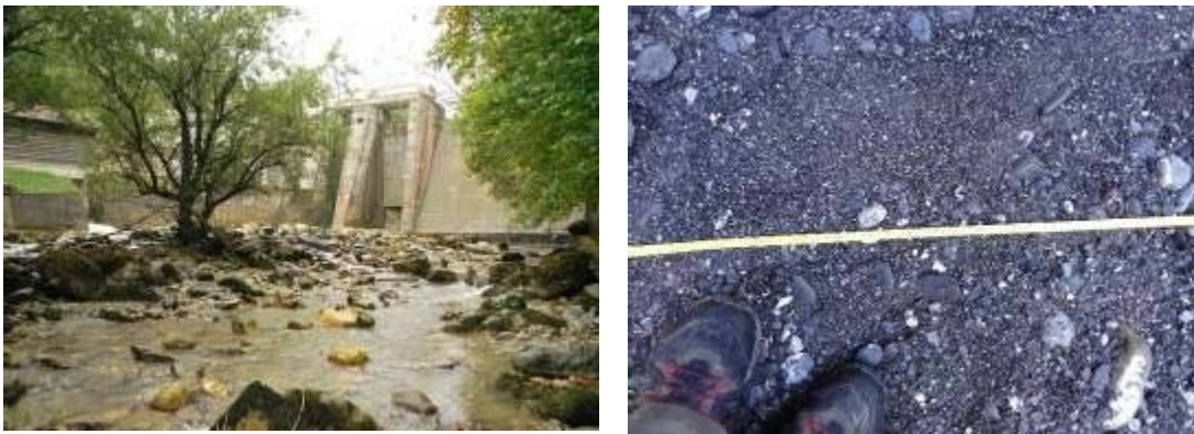
Figure 22: droite : barrage de l'Aubonne, gauche : en aval de la prise d'eau des Pars (Pk 3'660) sur l'Avançon d'Anzeinde, où le lit est constitué sur quelques centaines de mètres de matériaux nettement plus fins qu'en amont.
