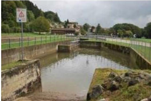
Figure 15 : Dépotoir sur la Saubrettaz en amont de Gimel (affluent de l'Aubonne)
