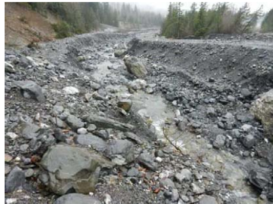
Figure 29: Chenal pilote creusé en 2007 et ses berges artificielles de 3-4m de hauteur (photos Service conseil Zones alluviales, 2011)
