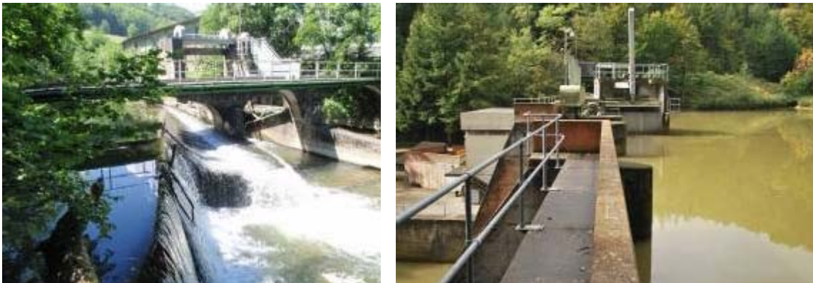
Figure 14: gauche: installation des Grands Moulins (71-502, Venoge), droite: barrage du SEFA (17-506, Aubonne)
