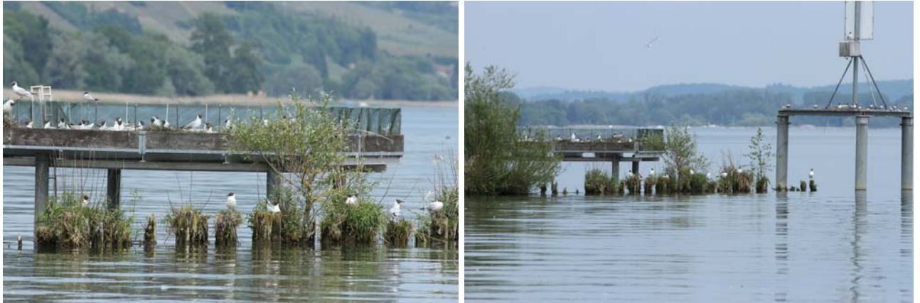
Fig. 33-34. Une nouvelle plateforme de nidification pour les Sternes pierregarins pourrait être construite à proximité de celle qui existe déjà. Les 2 feux qui seront démantelés pourraient également être transformés en petites plateformes de nidifications. Juin 2014, P. Rapin.
