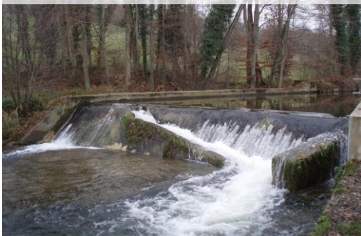
Exemple sur la Venoge d'un seuil transformé en rampe piscicole
