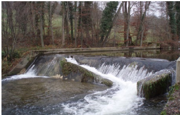
Exemple sur la Venoge d'un seuil transformé en rampe piscicole
