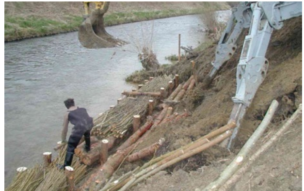
Fascines immergées à noyau sur la Broye §3.5, OFEV 2010
