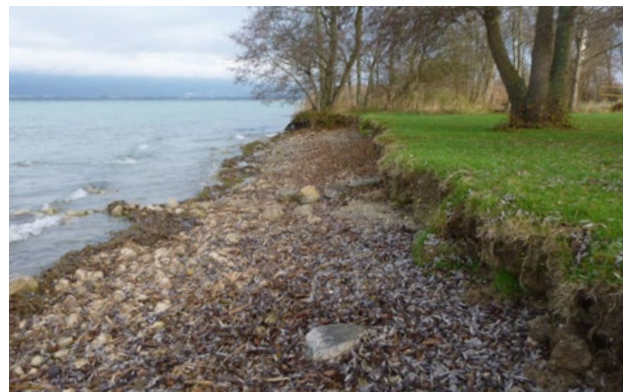
Erosion de la berge du lac à Cudrefin, Stucky 2018
