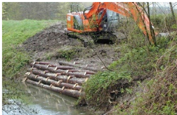
Reprise d'une niche d'érosion en caissons en bois sur l'Arbogne §3.12 OFEV 2010
