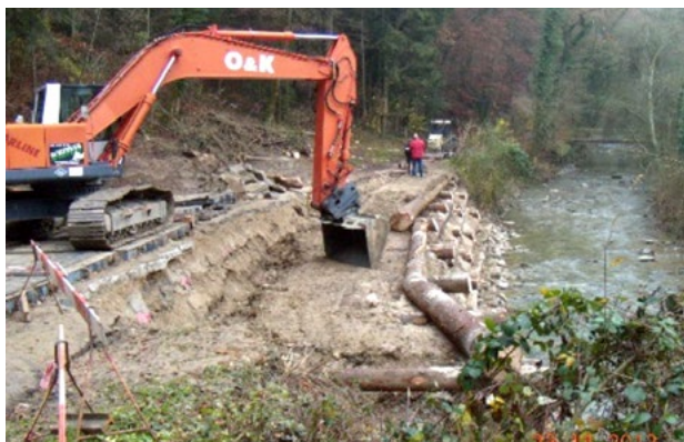
Berge en caissons en rondins sur le Talent
