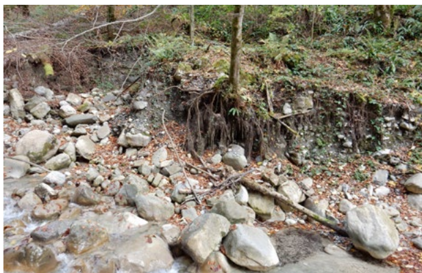
Erosion de la berge limitée par la végétation sur la Baye de Clarens
