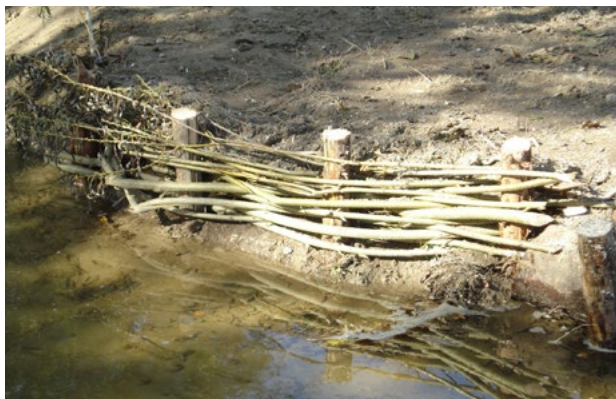
Tressage de saules sur les pieds de berges de petits cours d'eau §3.9 OFEV 2010
