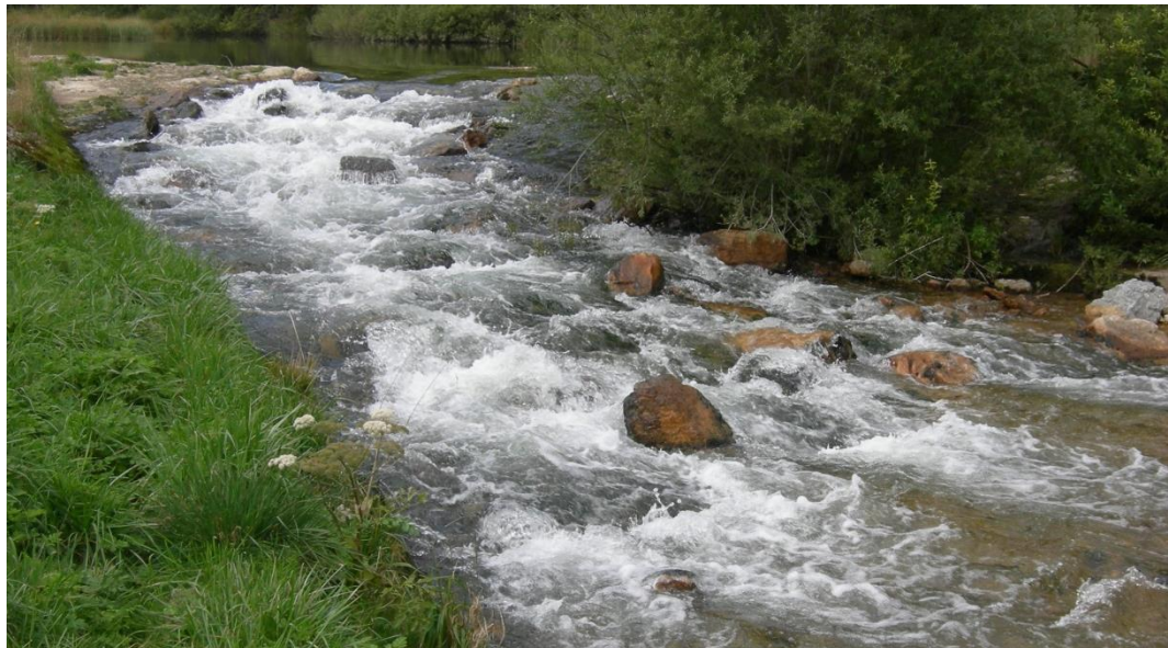
Figure 7 Exemple de rampe rugueuse sur l'Orbe (obstacle n°14, concession 277-511 Usines Métallurgiques de Vallorbe). Source : DGE-EAU, 2014.
