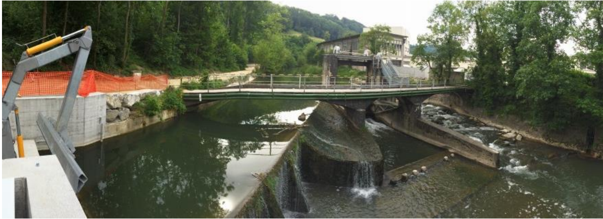
Figure 6 Centrale hydroélectrique réhabilitée sur la Venoge à Cossonnay (obstacle n° 37, anciennement concession n° 71-502, Provimi Kliba S.A. Source : DGE-EAU, 2014.
