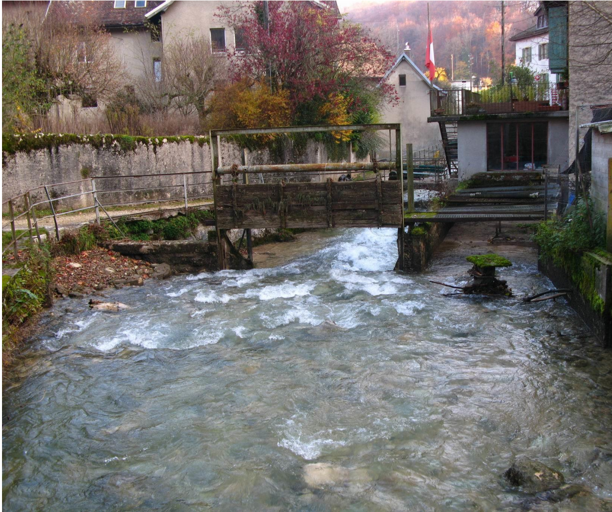
Figure 4 Exemple d'installation au bénéfice d'un droit d'eau perpétuel qui n'est plus en activité et qui ne nécessite pas de mesure actuellement, mais dont la remise en service devrait s'accompagner de mesures pour le rétablissement des déplacements piscicoles. Le Nozon à Romainmôtier, (obstacle n° 19, concession 274-505).
