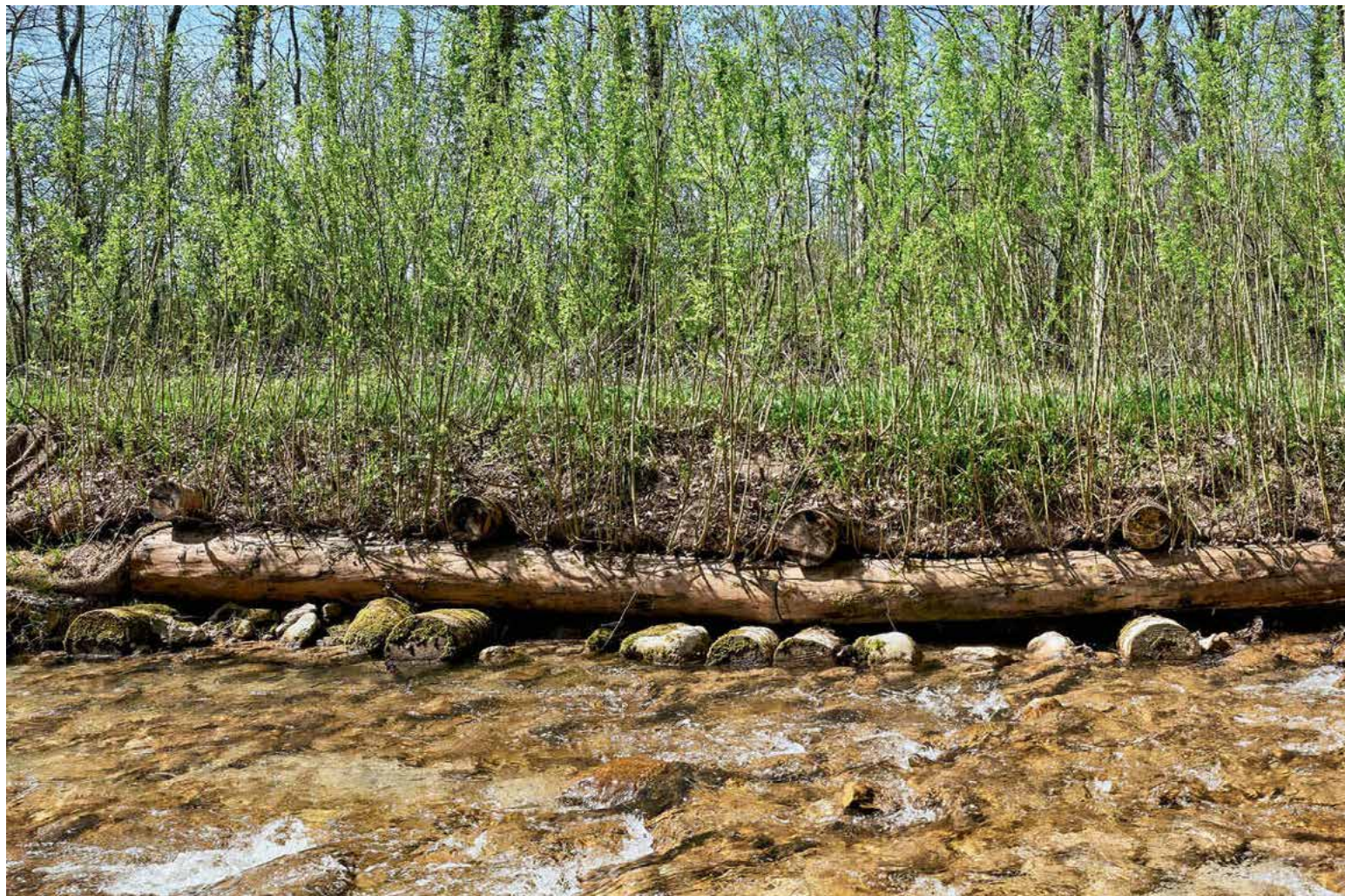
La Serine Commune de Vich Mise en place de caissons végétalisés et ouvrage permettant la migration piscicole (2013) Maître d'ouvrage : Commune
