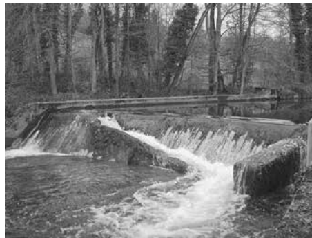
La Venoge avant les travaux.
