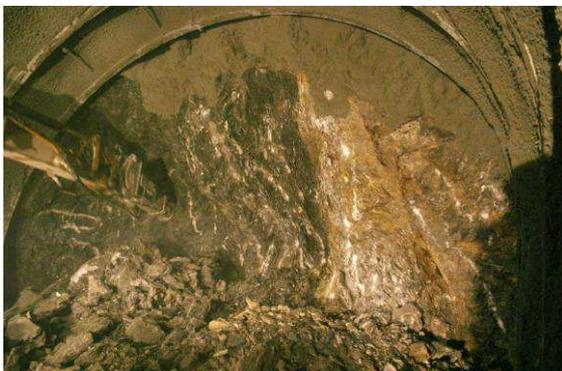
**Photo 13 :** Tm 704 - Contact flysch, couches rouges et calcaires (27.05.2008).
