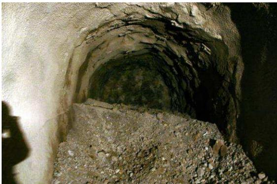
Photo 3 : Tm 583- Excavation dans le calcaire - Front après abattage à l'explosif (14.04.2008).
