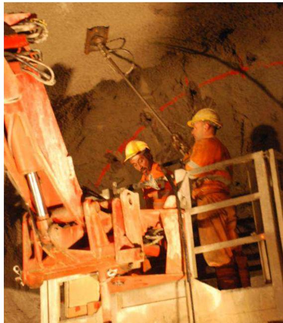
Photo 6 : Tm 615 - Pose des ancrages Swellex (22.04.2008).
