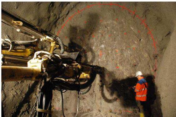
**Photo 11 :** Tm 638 - Vue du front lors de la phase de forage avec géologue (28.04.2008).
