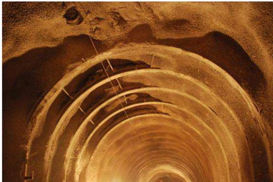
Photo 1 : Tm 537-552 - Soutènement avec 16 cintres métallique (08.04.2008).
