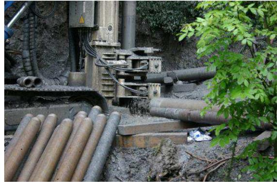
**Photo 16** : Forage drainant test exécuté depuis la surface- Détail tige de forage (05.06.2008).
