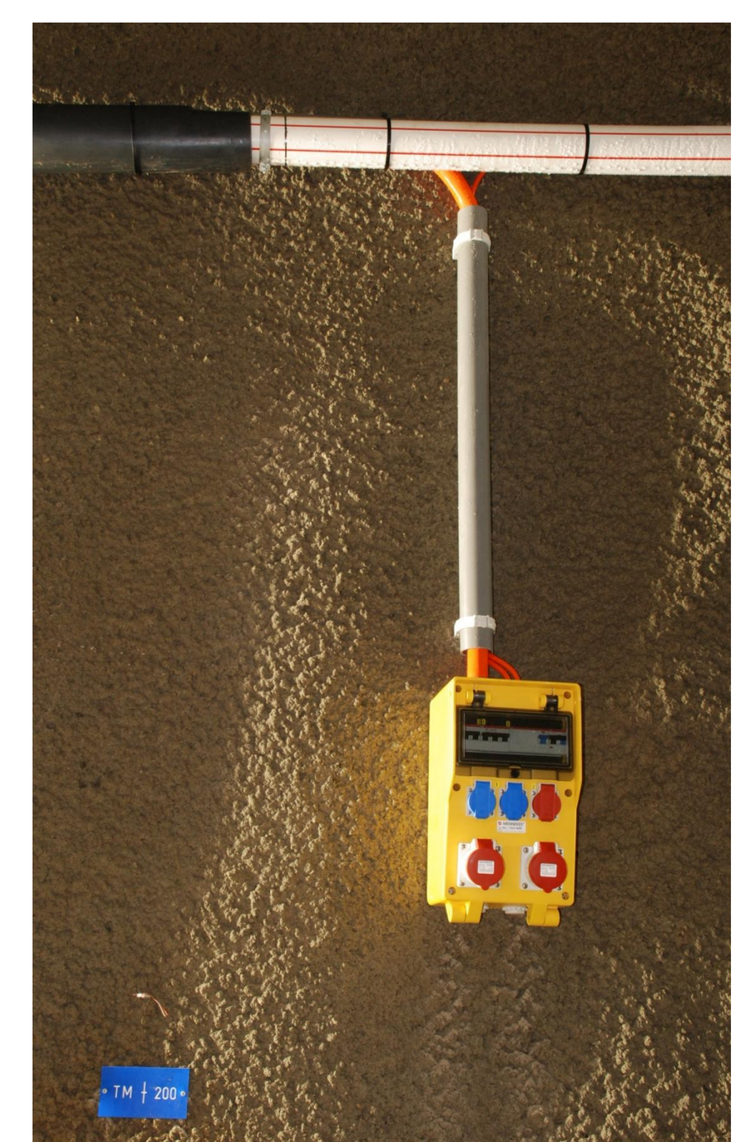
Photo 5: Tube à câbles avec l'un des quatre tableaux de distribution électrique au Tm 200
