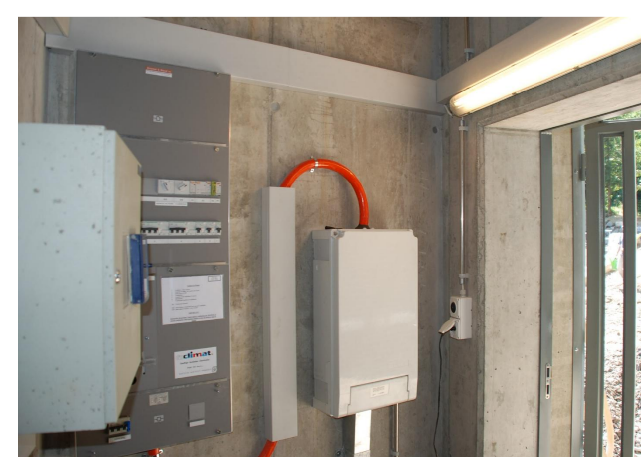
Photo 4: Local technique: boîtier d'introduction électrique, tableau électrique, et débitmètre
