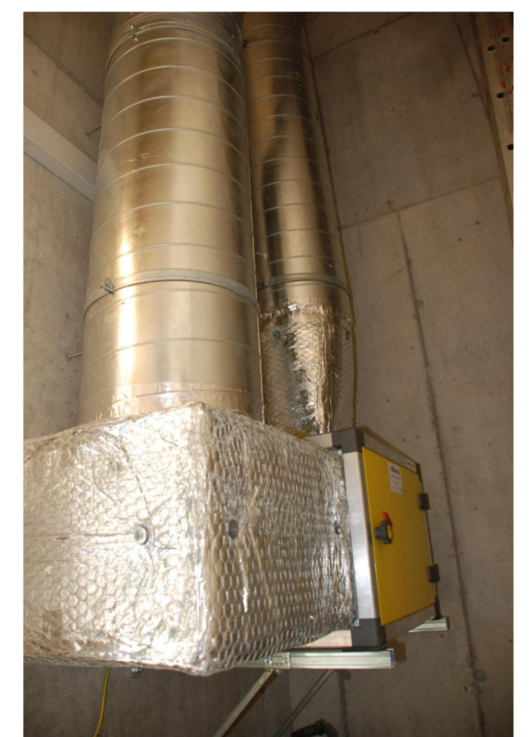
Photo 6: Monobloc de ventilation dans le local technique
