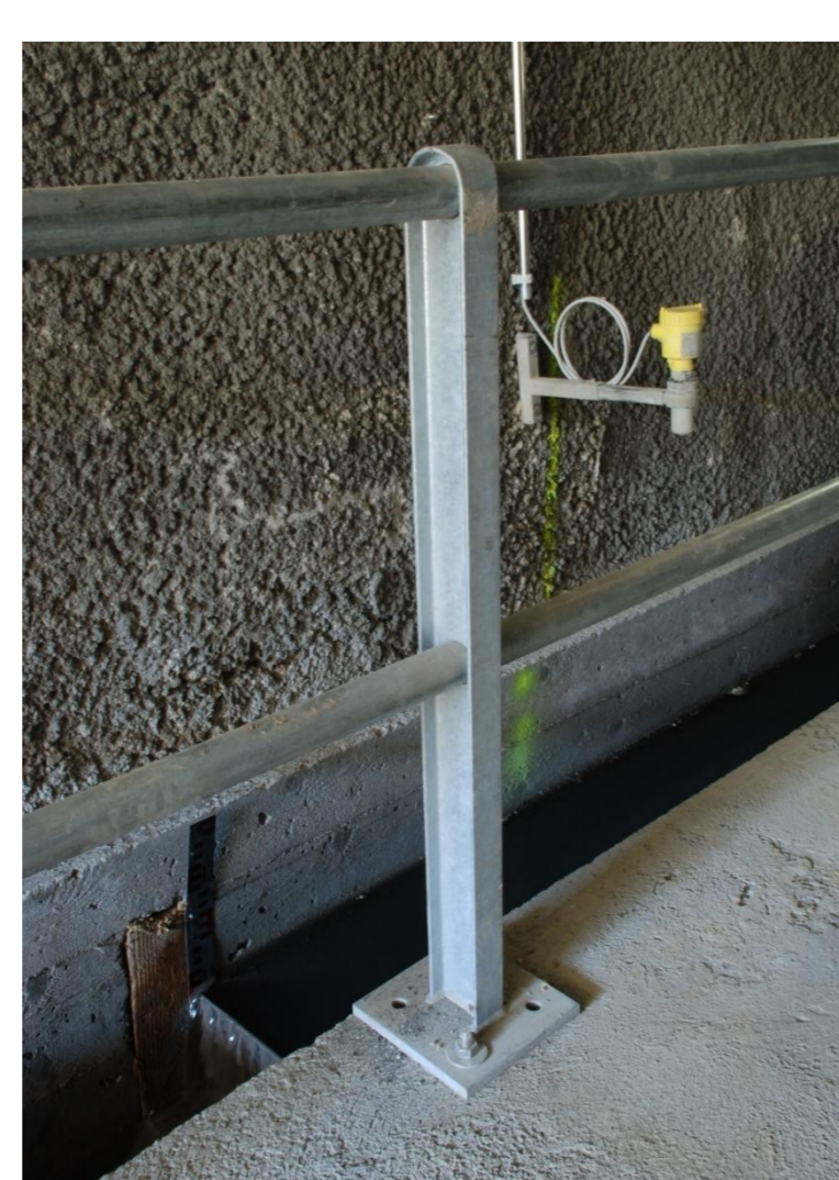
Photo 3: Station de jaugeage (débitmètre) à l'intérieur du portail et écran dans le local technique
