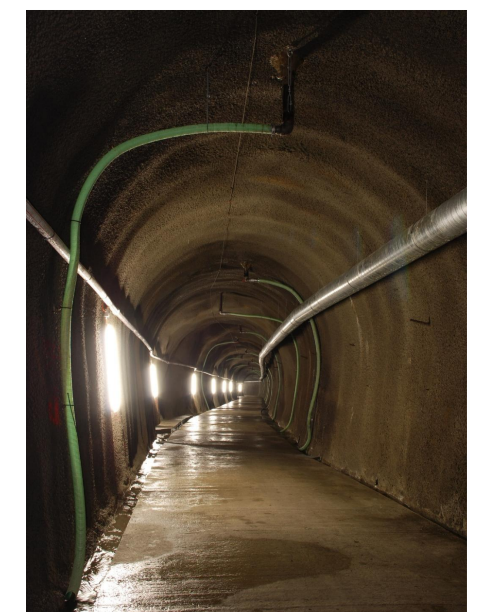
Photo 3: Vue de la série de drains avant la niche d'évitement
