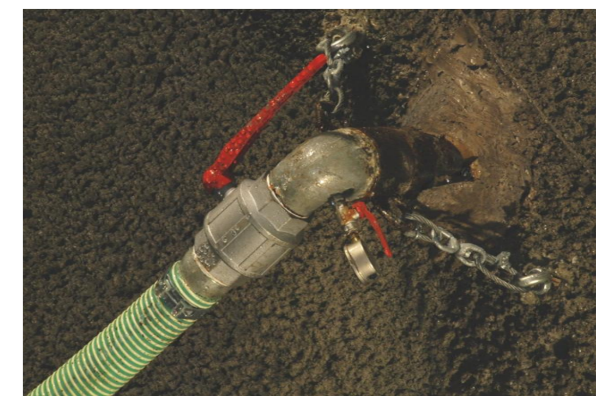
Photo 2: Détail fixation d'un drain équipé d'une vanne et d'un manomètre
