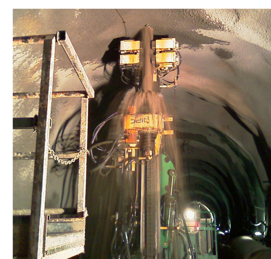
Photo 4: Venue d'eau dans le drain TM 377.5
