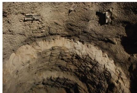
Une fois les trous de minage terminés, les mineurs chargent chaque trou avec des cartouches d'explosif à l'aide d'un bourroir. La première cartouche au fond du trou est connectée avec le détonateur. Les fils d'allumage des détonateurs qui sortent des trous sont ensuite regroupés et raccordés avec du cordeau détonant de 5g/m. La charge moyenne par volée de 3.20m de long est de 140kg et permet d'abattre 80m<sup>3</sup> de roche en place.
