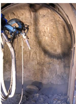
**Le soutènement:** Les trois profils-types utilisés pour la mise en place du soutènement sont illustrés ci-dessous. Si la roche est de bonne tenue, seule une couche de béton projeté et quelques ancrages sont nécessaires. Si la roche est mauvaise, le soutènement est complété chaque mètre par un cintre métallique. Le béton est projeté par le robot (photo ci-contre).
