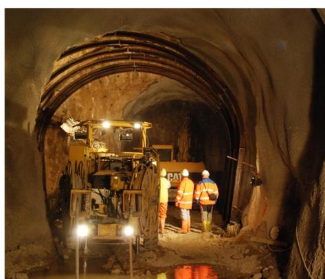
**Niche d'évitement:** Afin de pouvoir croiser avec les machines de chantier, un élargissement de 2.60m de large sur 25m de long a été réalisé. Cette niche se situe dans la cornieule au centre de la galerie. Elle a nécessité l'excavation supplémentaire de 400m<sup>3</sup> et la pose de 26 cintres métalliques. Une niche a également été construite en fin de galerie (Tm 690-715) afin de pouvoir tourner avec un véhicule.
