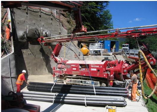
Exécution de la **voûte parapluie au portail** début août 2007. Mise en œuvre de 21 tubes D=152mm de 12m de long en calotte de la voûte, à l'aide d'une foreuse. Ces tubes ont ensuite été injectés avec 5 tonnes de mortier.
