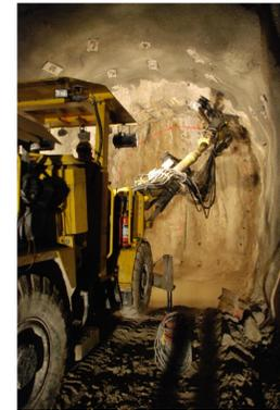
Le jumbo fore également les trous pour la **pose d'ancrages passifs en calotte**. Ces ancrages évitent les chutes de blocs. 1'200 ancrages ont ainsi été posés.
