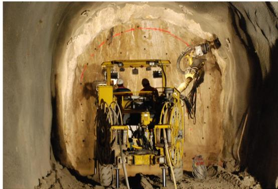
Le **jumbo à 2 bras** fore 61 trous de diamètre 41mm plus 2 trous vides de diamètre 127mm selon un plan de tir bien précis. Cette opération nécessite 3 heures environ dans les roches dures (calcaire) et 1.5 heures seulement dans la cornieule.
