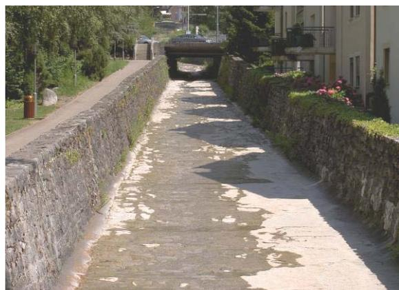
*Exemple de rivière canalisée, sans rives. Les surfaces urbanisées s'étendent jusqu'au bord de l'eau. Le très faible débit permet d'observer l'aménagement total du fond du lit à l'aide d'un pavage de pierres.*
