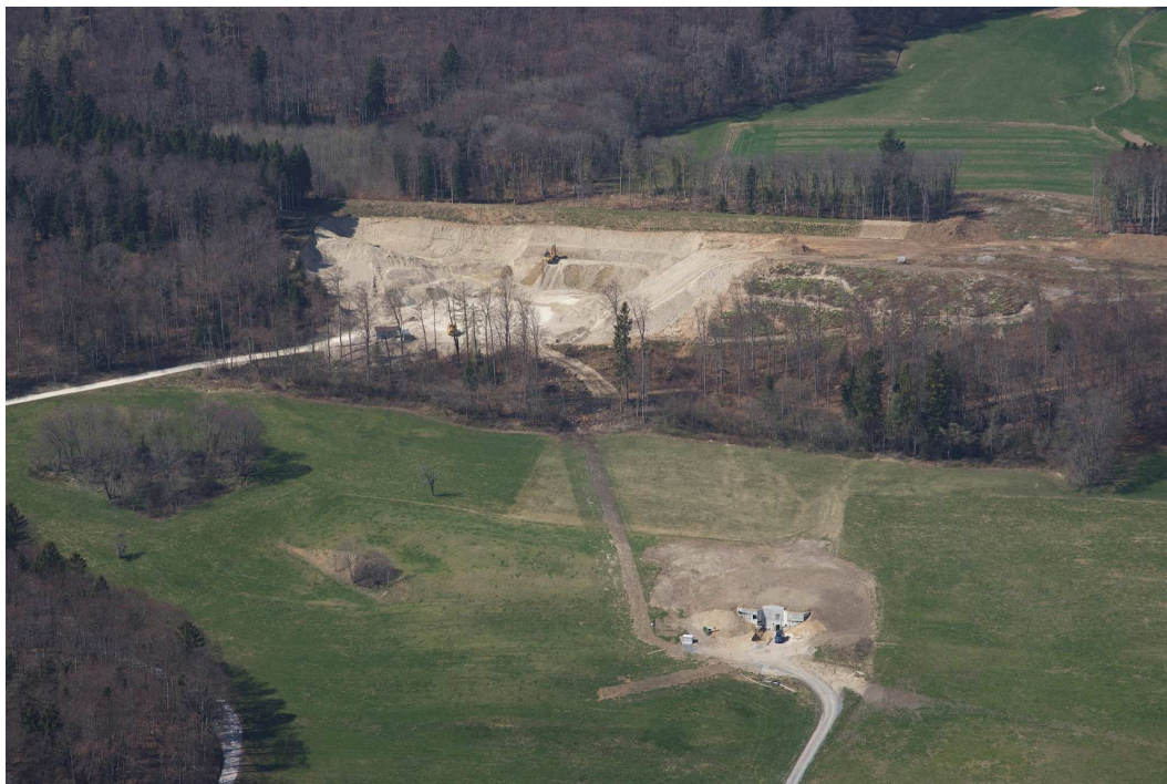
Photo 5 : Construction du barrage souterrain de la Commune de l'Isle au captage dit des "Barbilles", destiné à stocker l'eau de la nappe. On distingue le réservoir de redistribution, en bas à droite. Photo aérienne JM Zellweger, avril 2012.
