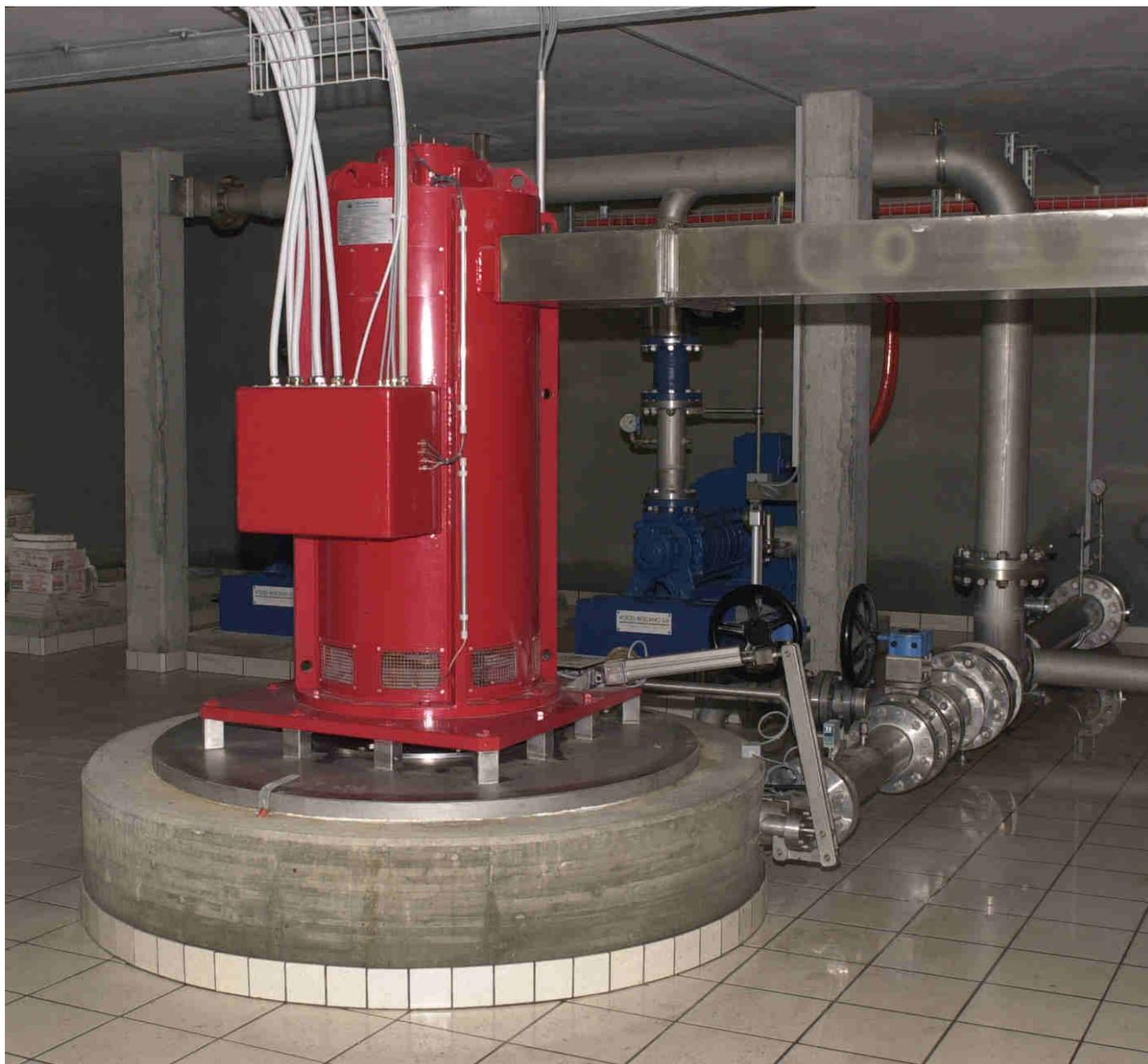
Figure 1 : Turbinage d'eau potable de Chenalettaz I (Ollon), 245 kW
