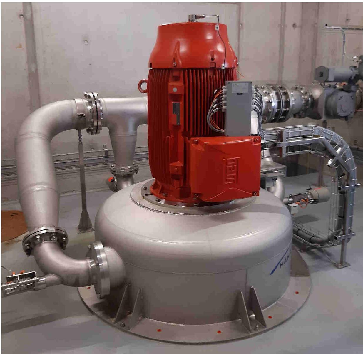
Figure 67 : Turbinage des eaux claires du Bief Rouge (Vallorbe), 72.kW
