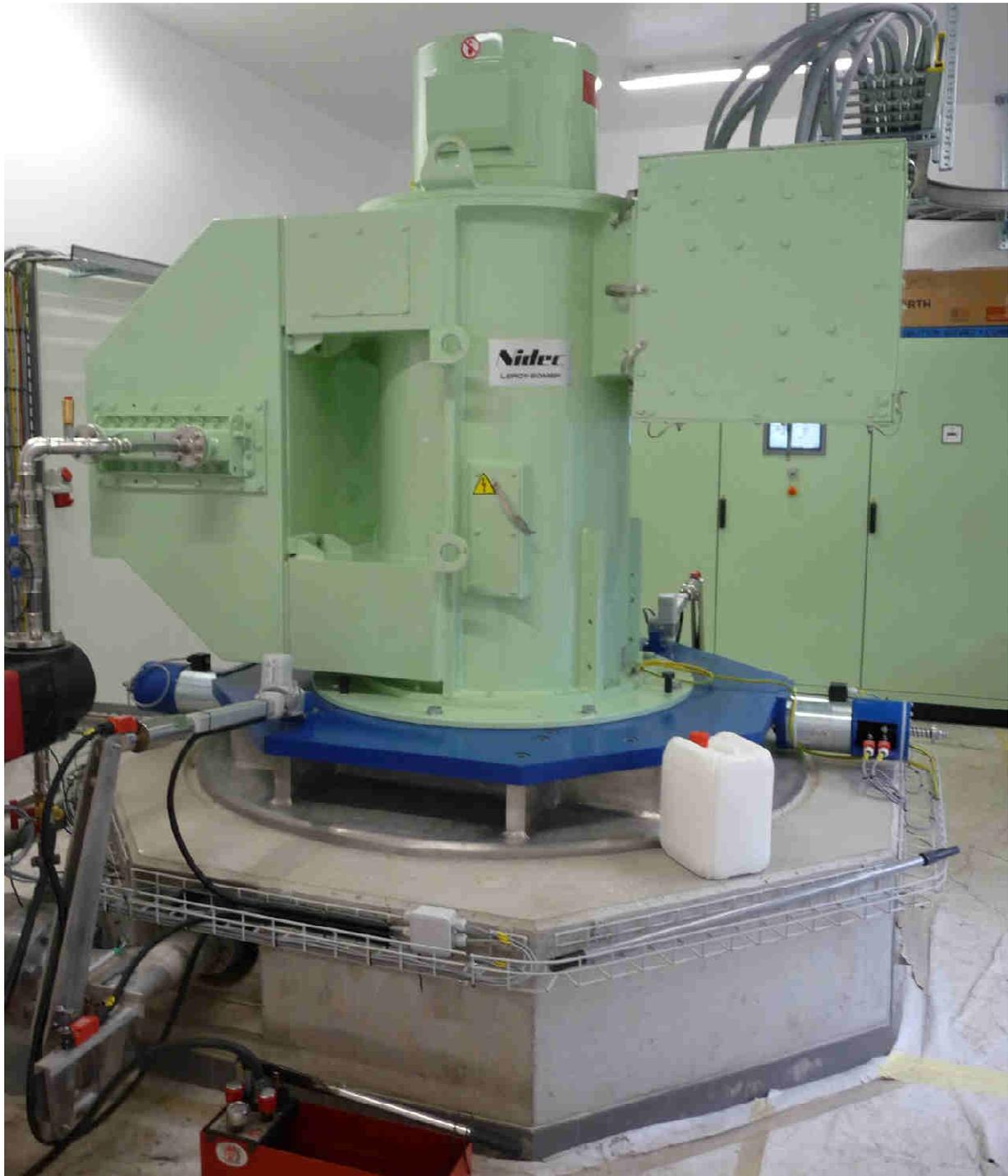
Figure 57 : Turbinage d'eau potable de la Rippaz (St-Triphon), 711 kW.
