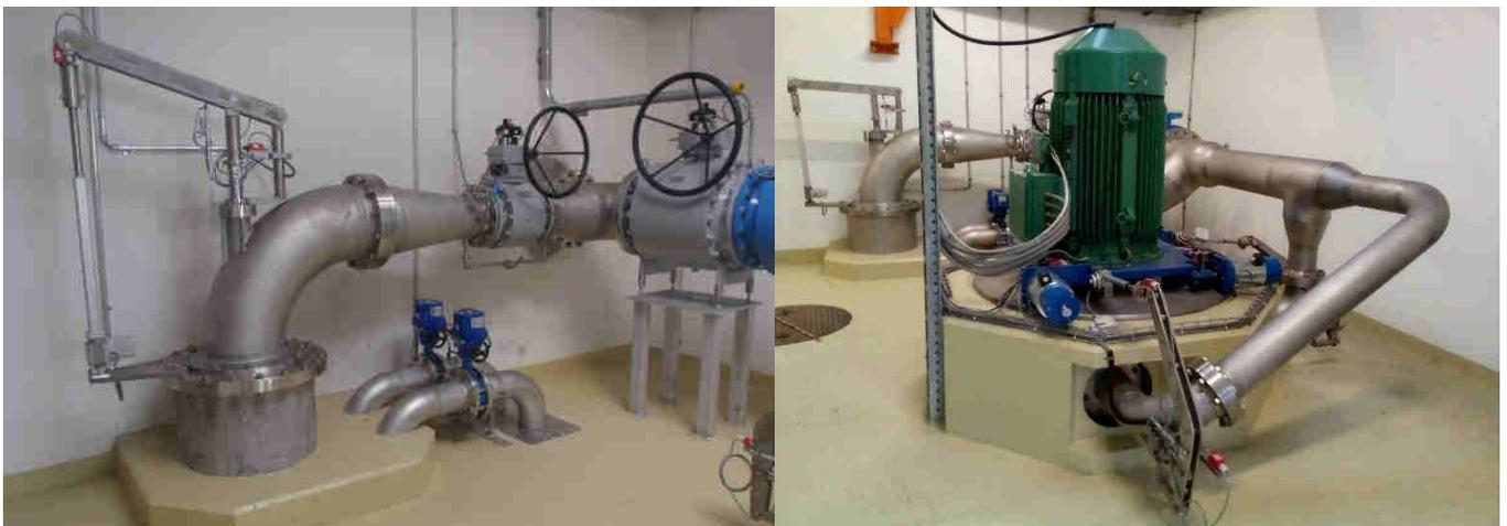
Figure 19 : Turbinage d'eaux usées après traitement, by-pass et turbine, STAP de Coppet (SITSE)
