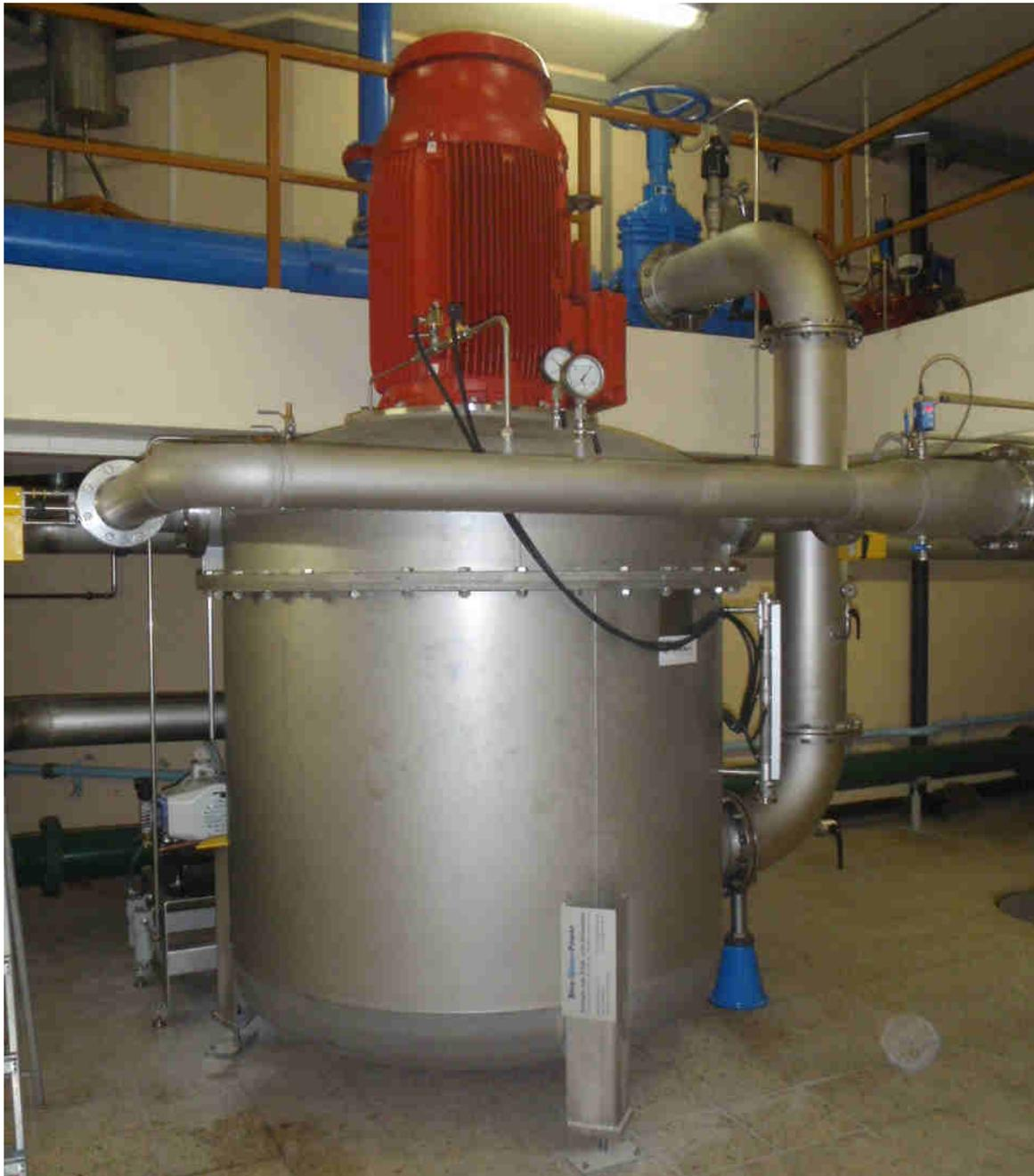
Figure 68 : Turbinage d'eau potable de Haute-Pierre (Echichens), 65 kW
