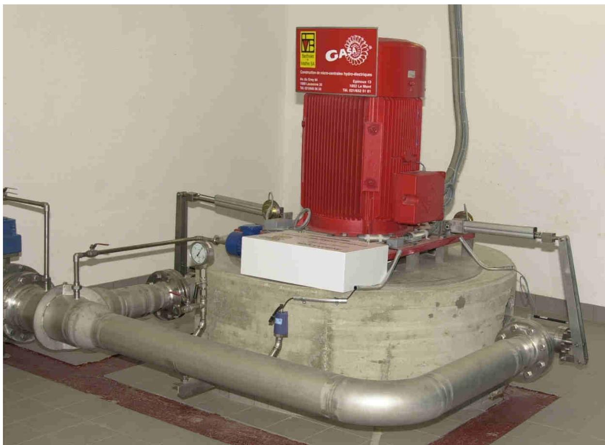
Figure 20 : Turbinage d'eau d'irrigation de l'Armary (Aubonne), 68 kW
